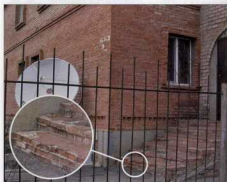
Рис. 4. Кладка ступеней из пустотного кирпича
